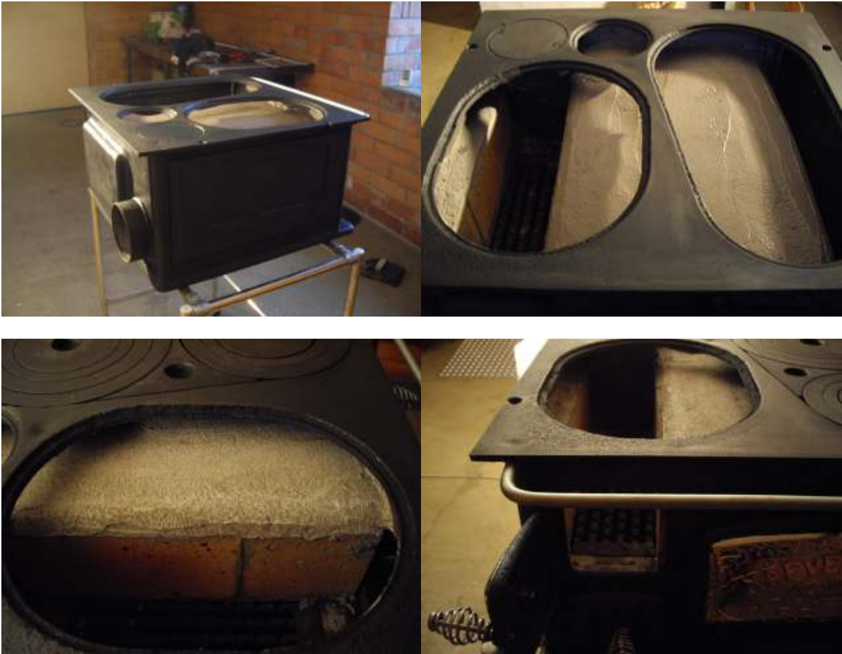
Murning och gjutning i eldstad och över ugn
